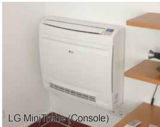
Aufputz mit Eck-Kondensatpumpe
