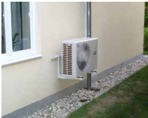
Single-Split Ausseneinheit 3,5kW
