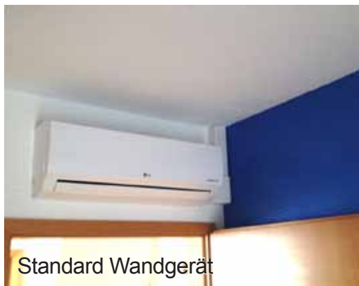
Aufputz mit Eck-Kondensatpumpe
